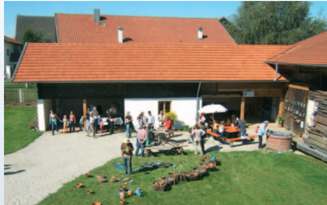
Stadel und Mitterstallbau beim „Gratz“ in Bölldorf 5
